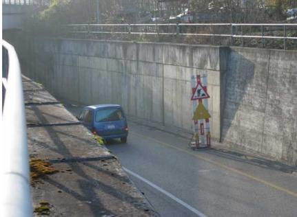
Le décrochement, au-dessus du signal « travaux », correspond à l'appui du pont de la route H18 prévue.
