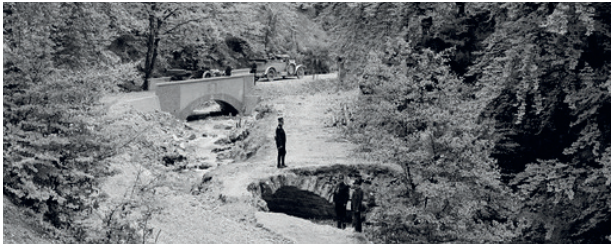
Nouveau et ancien pont, à la bifurcation de la Neuvevie, en 1915
