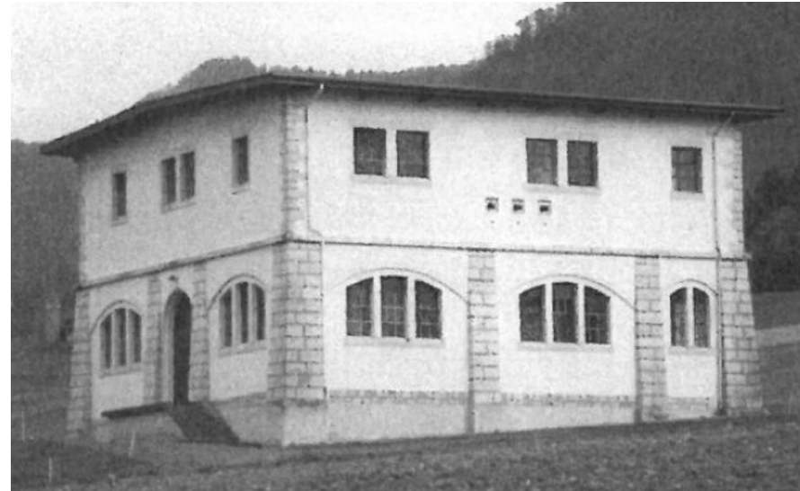
Sous-station de Mervelier
